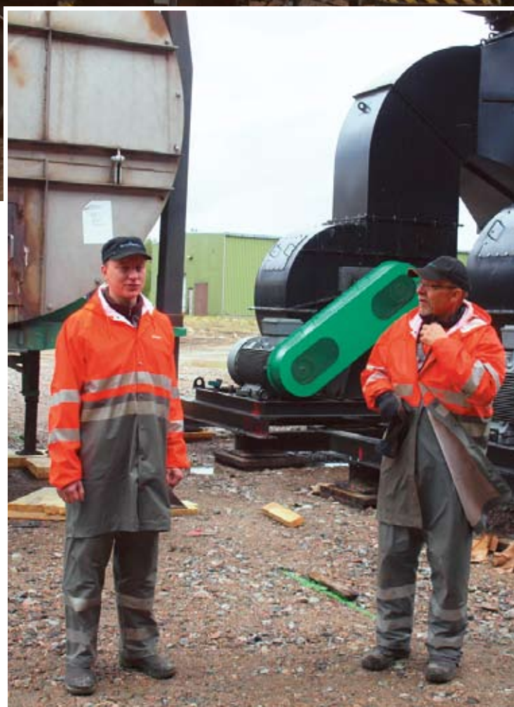
Tero Alajoutsijärvi (vas.) ja Jaakko Alajoutsijärvi Savaterrasta pystyttävät puhdistuslaitosta ja tarvittavia rakenteita vielä heinäkuun alkupuolella.
