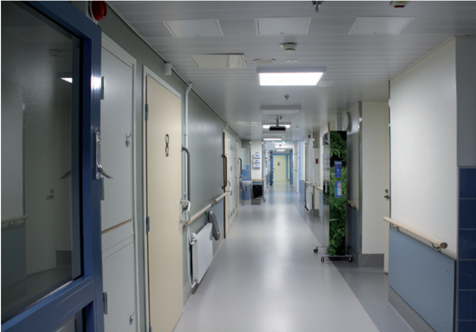
Sallan terveyskeskuksen remontti alkaa olla loppusuoralla. Uusittu akuutti- ja kuntoutusosasto on jo otettu käyttöön ja sosiaalipalveluiden toimitilat valmistuvat osastosiiven paikalle toukokuussa.
