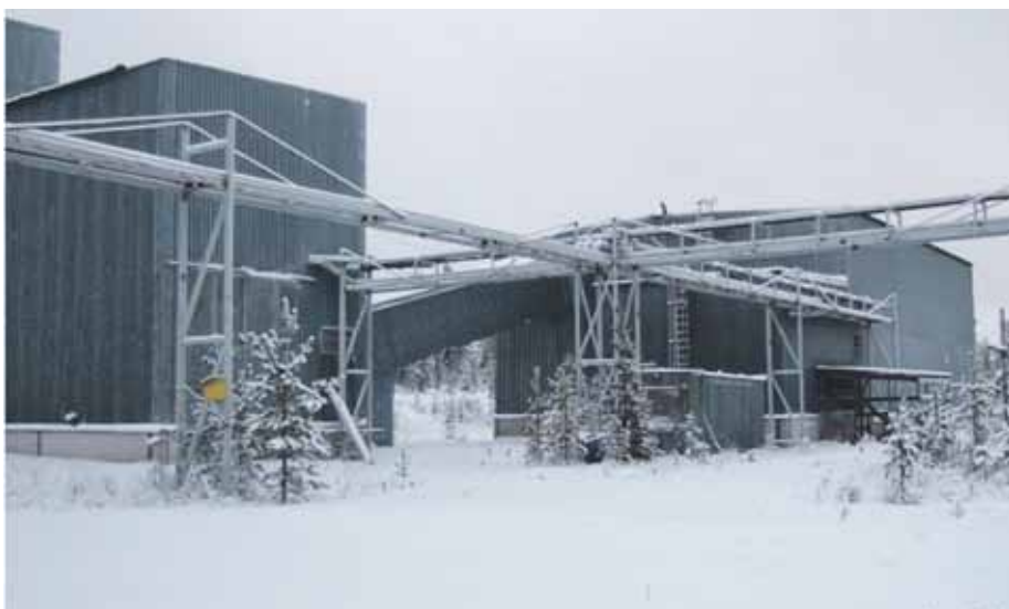
Sokliin aikoinaan rakennettu koerikastamo.
