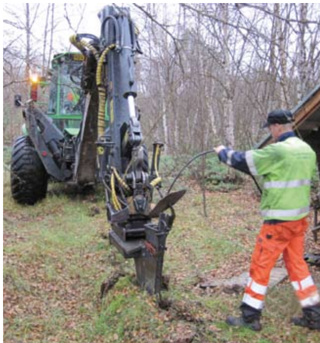
Kiinteistökaapelin aurausta Utsjoella.
