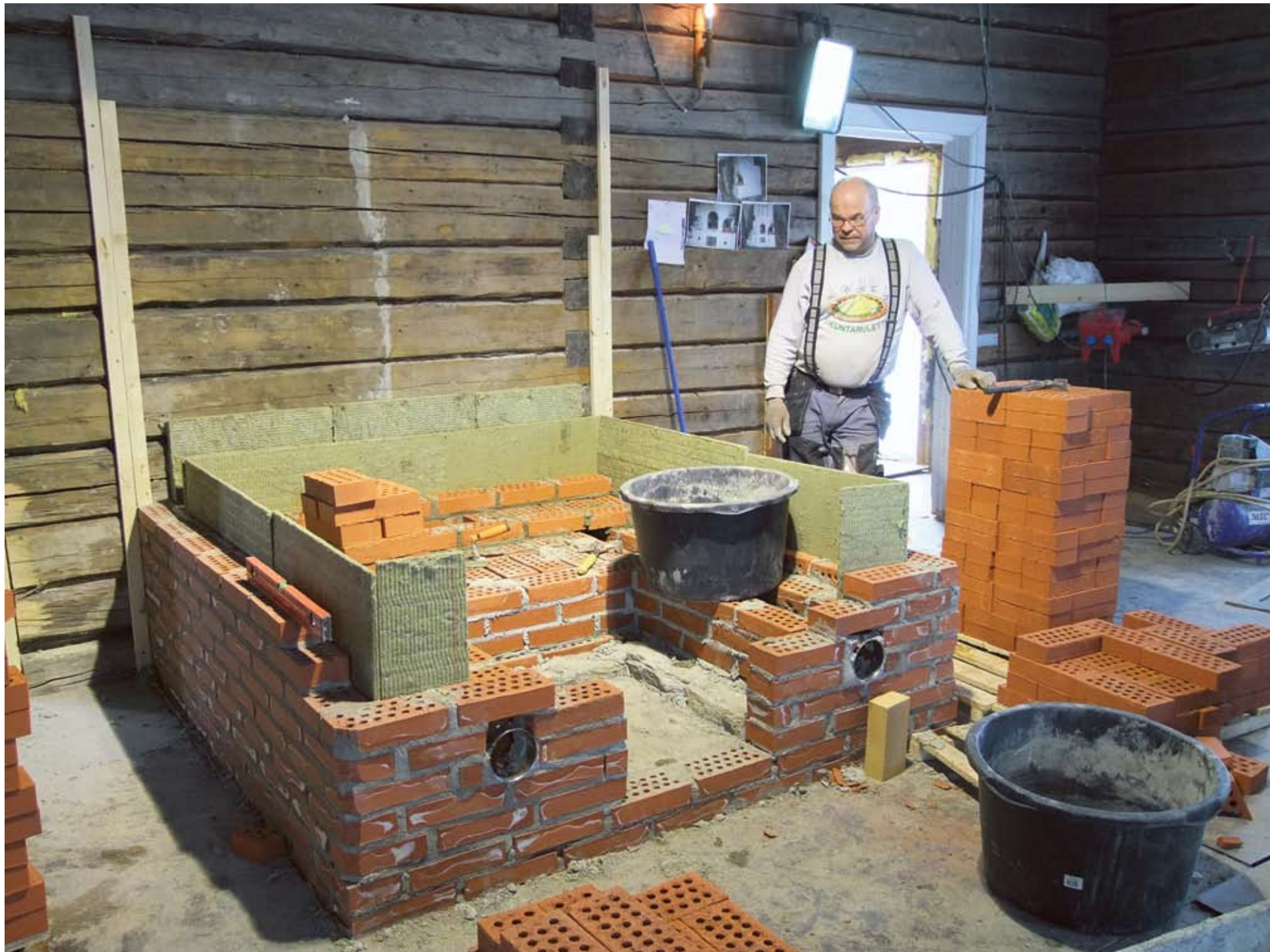
Museon pihapiiriin siirretty rajakieväri, entinen kotiseututalo, valmistuu käyttökuntoon kesäksi. Muurari Sampo Anttila muuraa pirtin uunia.
