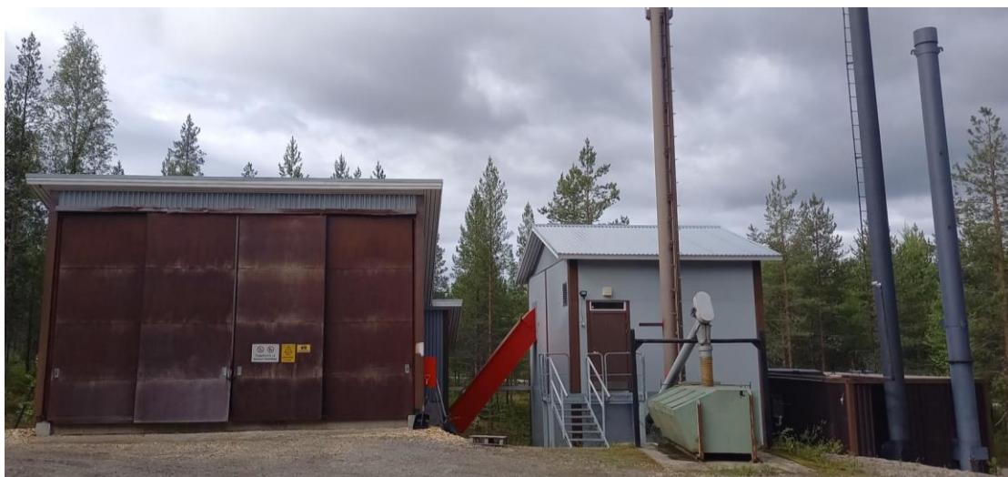
Kuva 6. Alueella sijaitseva lämpölaitos.
