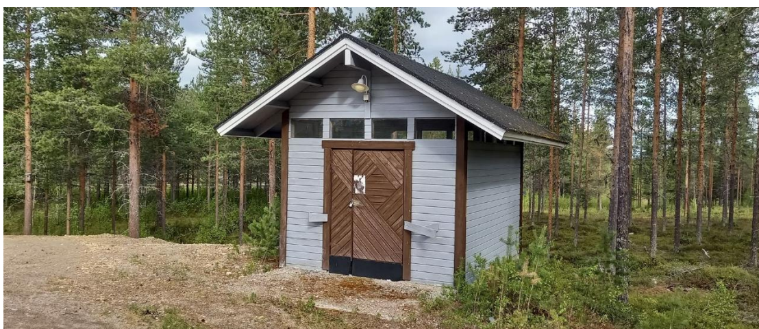
Kuva 7. Lämpölaitoksen alueella sijaitseva varastorakennus.
